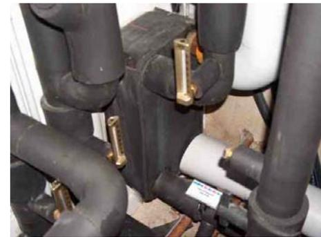
Abbildung 32 - Wärmepumpe mit Steuereinheit (oben) und Solepumpe (unten links) sowie Plattenwärmetauscher (unten rechts)
