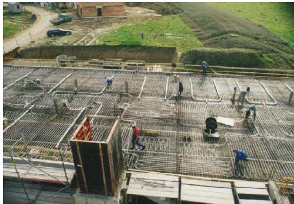
Abbildung 33 - Anlieferung und Verlegung der BKT-Matten
