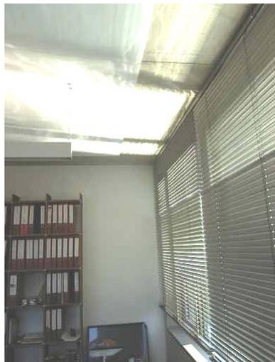
*Abbildung 82: Blendschutz mit Licht lenkender Funktion im oberen Drittel*
