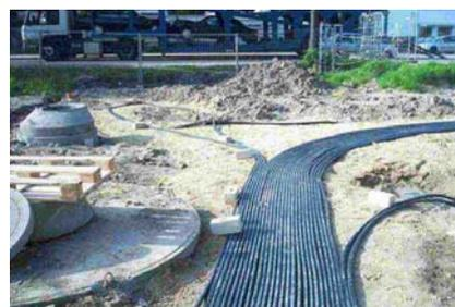
Abbildung 31 - Einbringung und Anschluss der Erdsonden
