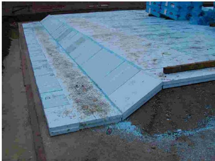
Abbildung 25 - Dämmung der Bodenplatte
