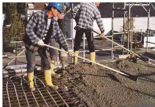
Abbildung 34 - Verlegung der BKT-Matten und Druckprüfung
