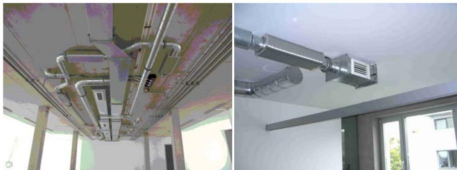
Abbildung 37 - Lüftungskanäle in der Mittelzone und Lüftungsauslass in einem Besprechungsraum
