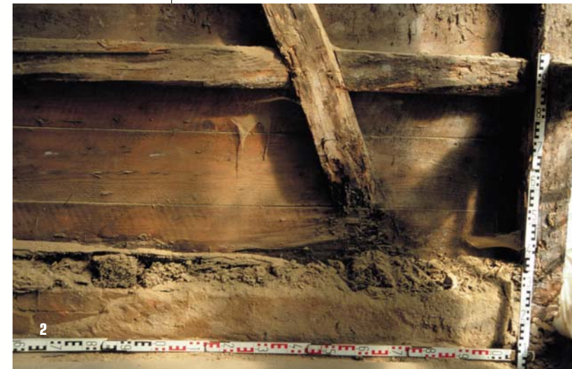
Abb. 1: Ein Lehmgefach entsteht. Abb. 2: Fäulnisschaden an einem Fachwerkbalken.
