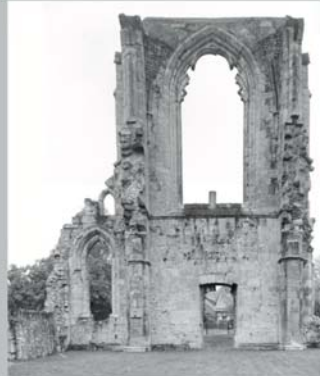
K-02 Westfassade - Ostseite / Blickrichtung Westen
