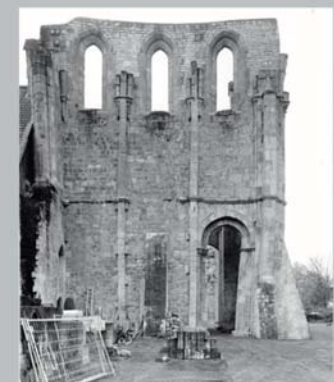
K-13 Südquerhaus - Westwand / Blickrichtung Westen
