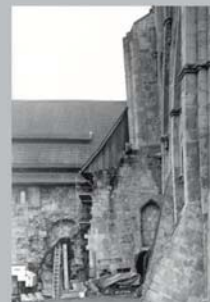
K-12 Südquerhaus - Nordseite / Blickrichtung Süden
