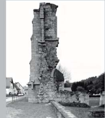
K-04 Westfassade - Südseite / Blickrichtung Norden
