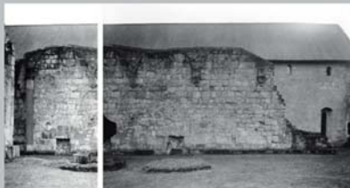
K-05 Langhaus - Südwand / Blickrichtung Süden
