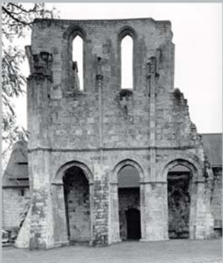
K-06 Langhaus - Südseite / Blickrichtung Süden ehem. südl. Jochreihe
